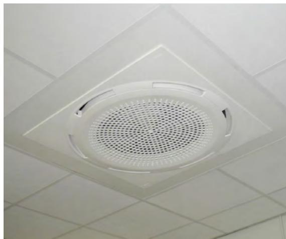
Biddle-Klimakassetten können sowohl vor der Montage einer Systemrasterdecke als auch nachträglich installiert werden. Durch das verstellbare Montagesystem lässt sich das Gerät in alle Richtungen verschieben. So kann die korrekte Position genau bestimmt und das Gerät einfach in die Decke integriert werden.
